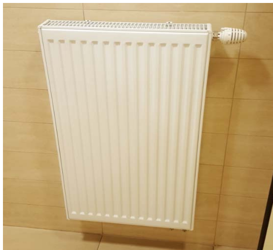
Slika 6.5: Radiator s termostatskim ventilom
