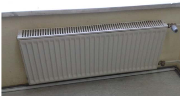
Slika 6.4: Radiator z navadnim ventilom
