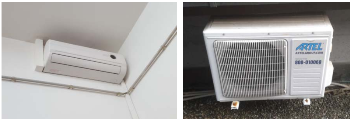
Slika 7.17: Split klimatska naprava z notranjo in zunanjo enoto
