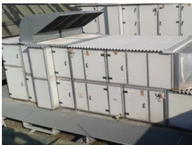
Slika 7.13: Prezračevalni napravi na strehi (~1987)
