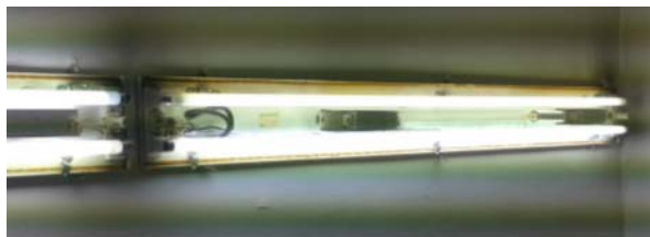
Slika 7.11: Razsvetljava brez pokrova
