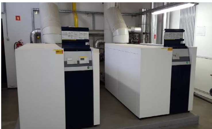
Slika 6.1: Posnetek plinskih kotlov (2001)
