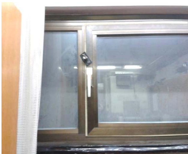
Slika 7.3: Primer okna na objektu SNG Maribor – ročna pritrditev
