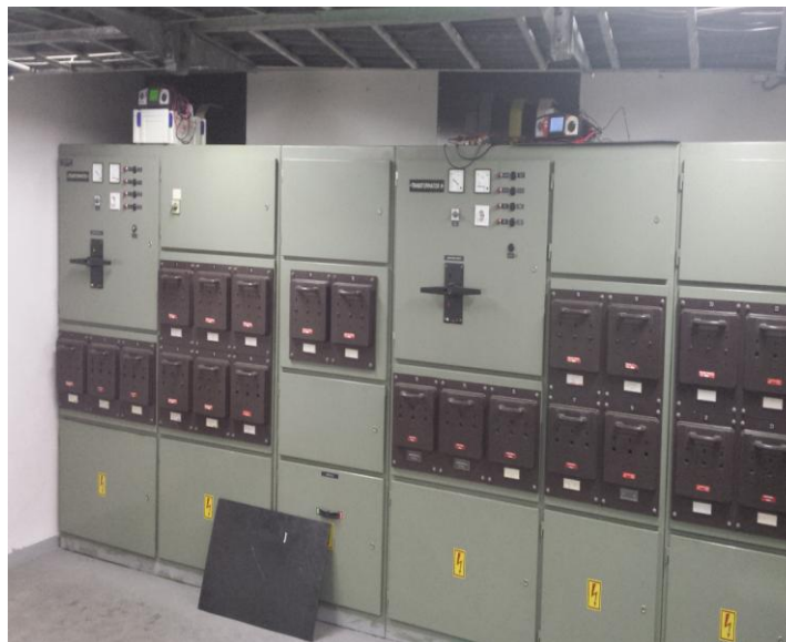
Slika: Pročelje zgradbe SNG Maribor, zbiralno mesto TRI in TRII z zaščitnimi elementi v glavni elektro-omari NN in centralna kompenzacijska naprava TRI
