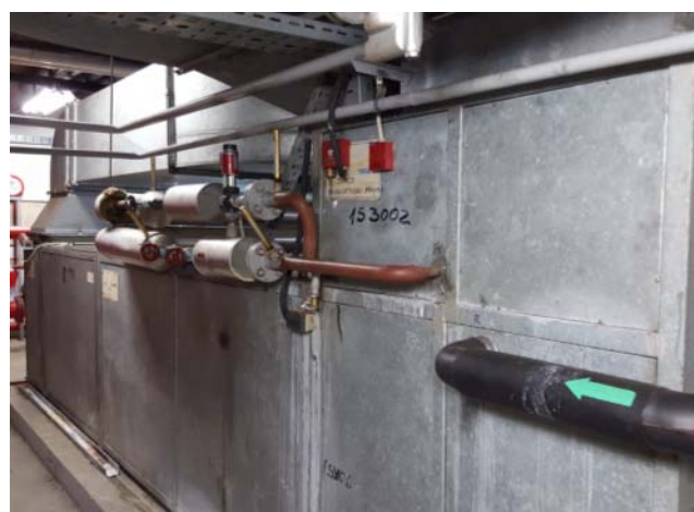
Slika 7.14: Prezračevalna naprava vidno dotrajana (~1987)
