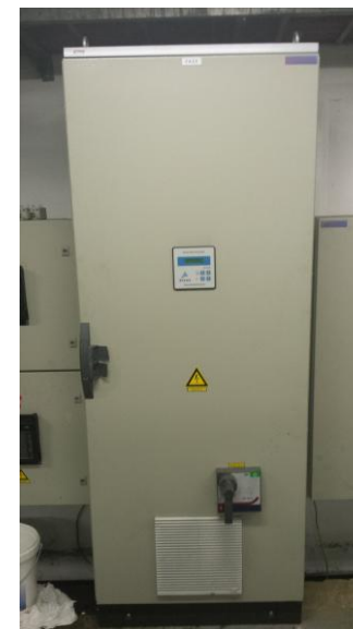
Slika: Pročelje zgradbe SNG Maribor, zbiralno mesto TRI in TRII z zaščitnimi elementi v glavni elektro-omari NN in centralna kompenzacijska naprava TRI
