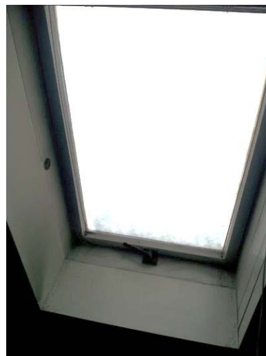
Slika 7.4: Primer ne zatesnjenosti med strešnim oknom in strešno konstrukcijo
