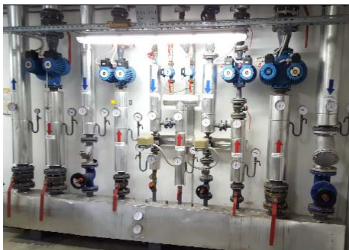
Slika 6.3: Toplotni razdelilnik
