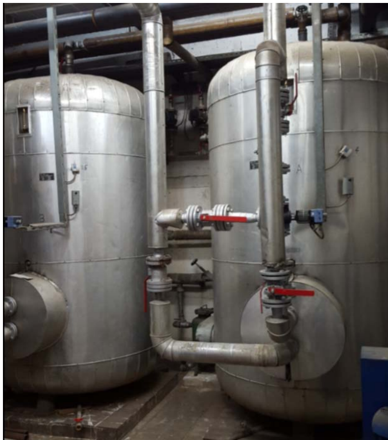
Slika 6.7: Bojlerja za pripravo TSV (1981)
