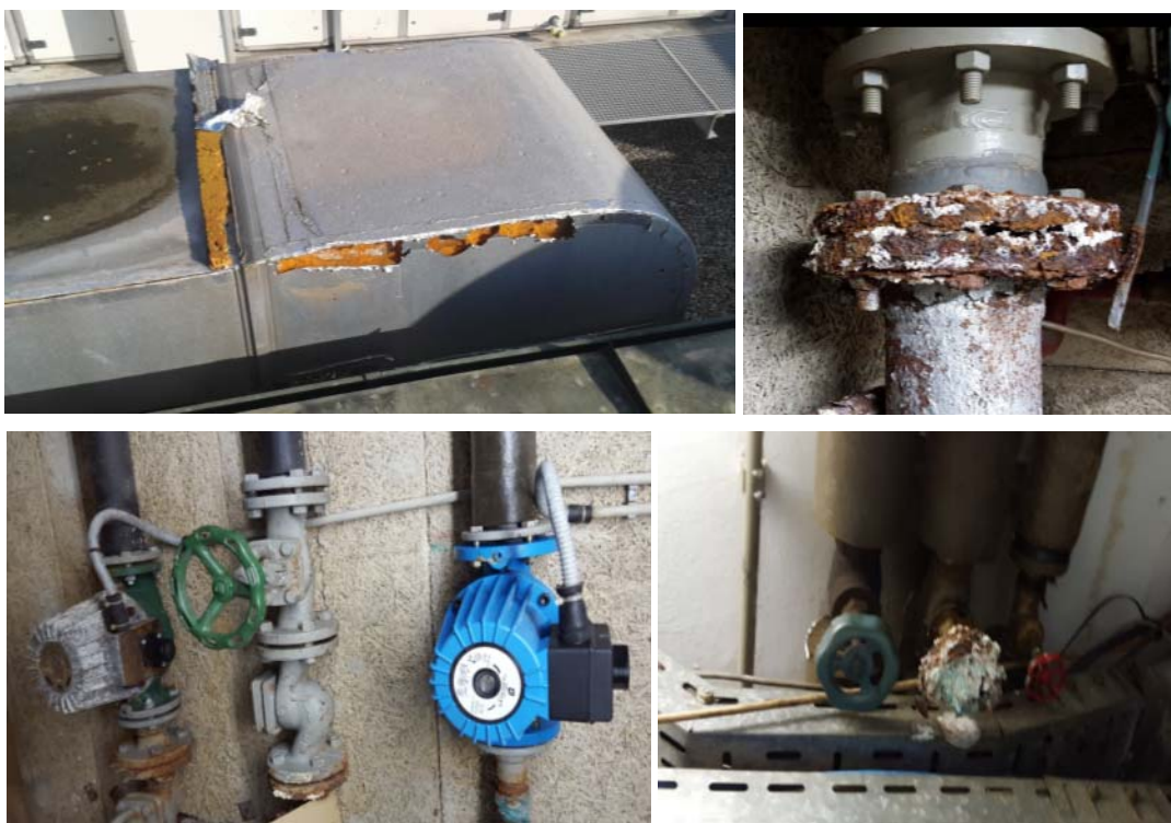
Slika 7.15: Vidno dotrajane inštalacije prezračevanja in ogrevanja
